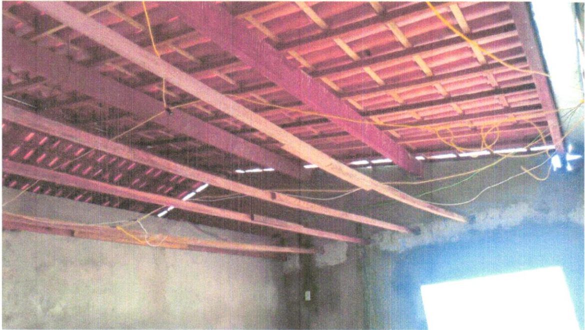
FOTO 09 - CABO DE COBRE FLEXÍVEL ISOLADO, 1,5 MM 2 , ANTI-CHAMA 450/750 V, PARA CIRCUITOS TERMINAIS - FORNECIMENTO E INSTALAÇÃO. AF_12/2015
