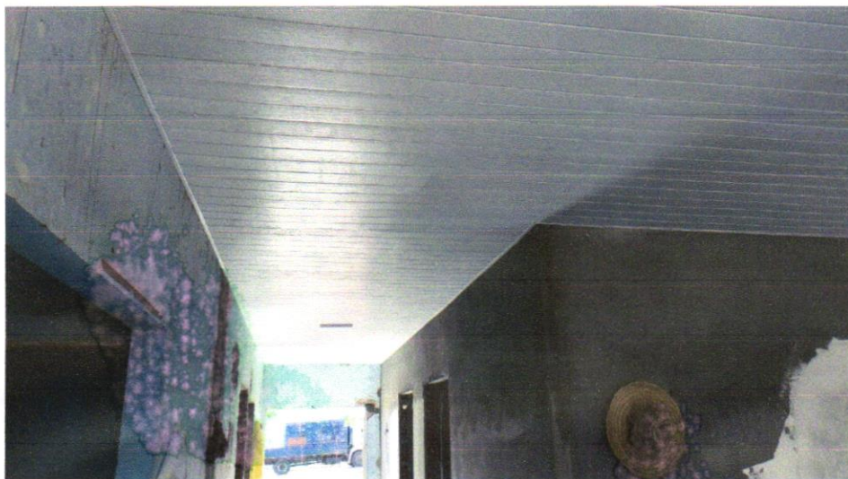
FOTO 8 – FORRO DE PVC FRISADO BRANCO 4,0X0,20M
