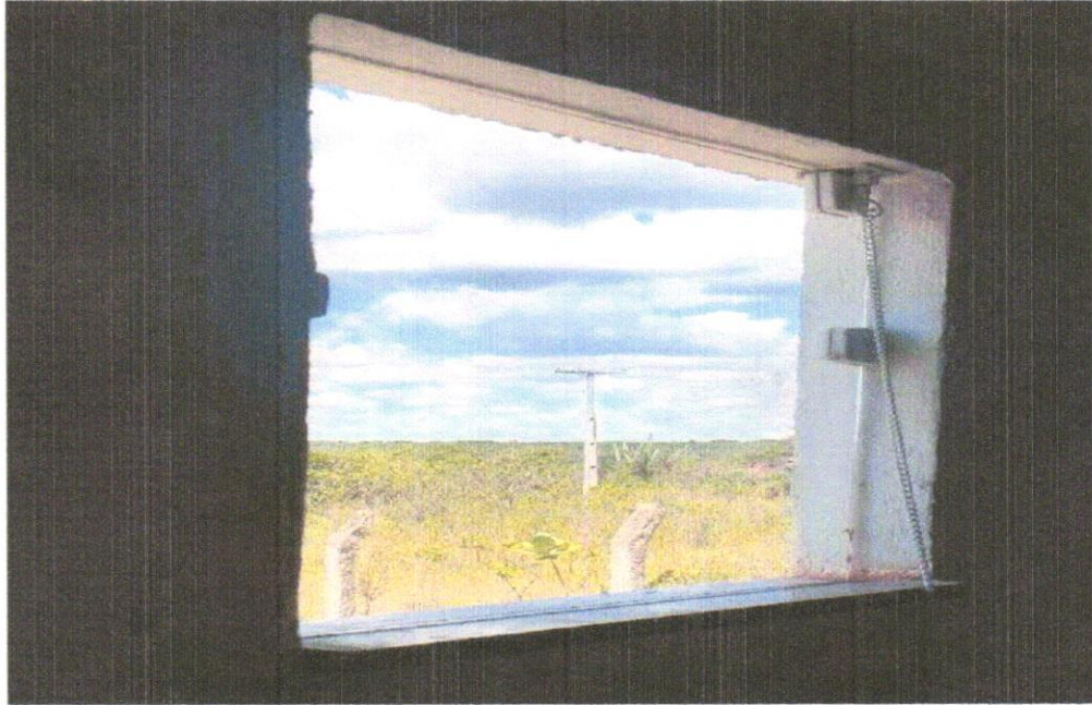
Foto 13 – JANELA DE ALUMÍNIO TIPO MAXIM-AR, COM VIDROS, BATENTE E FERRAGENS. EXCLUSIVE ALIZAR, ACABAMENTO E CONTRAMARCO. FORNECIMENTO E INSTALAÇÃO. AF_12/2019
