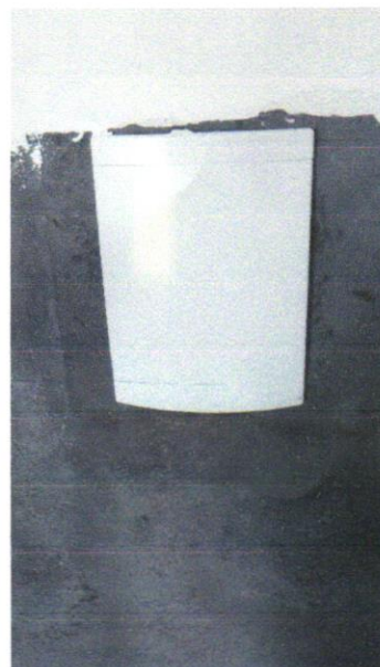
FOTO 06 – QUADRO DE DISTRIBUIÇÃO DE EMBUTIR, EM RESINA TERMOSPLÁSTICAS, PARA ATÉ 16 DISJUNTORES, COM BARRAMENTO, PADRÃO DIM, EXCLUSIVE DISJUNTORES
