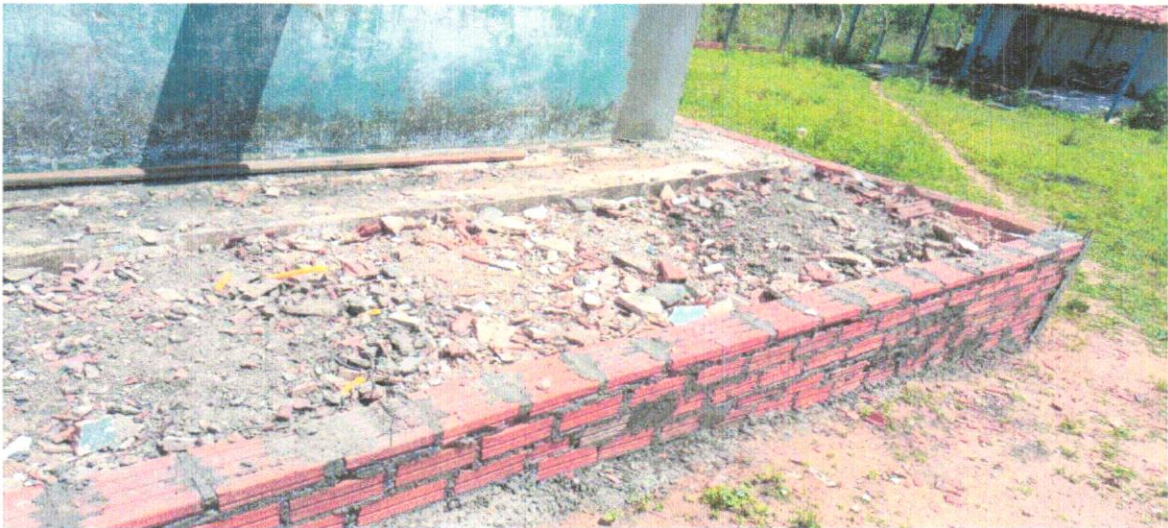
FOTO 11 – ALVENARIA DE VEDAÇÃO DE BLOCOS CERÂMICOS FURADOS NA HORIZONTAL DE 9X19X29 CM (ESPESSURA 9 CM) E ARGAMASSA DE ASSENTAMENTO COM PREPARO EM BETONEIRA. AF_12/2021
